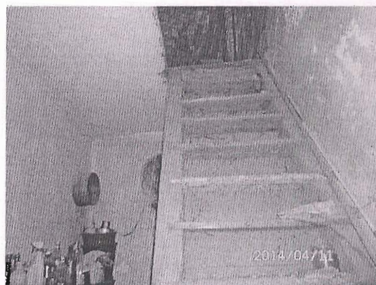
Kamra, padlás feljáró
