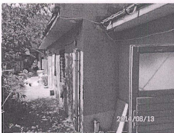
Társasház B jelű épület homlokzata
